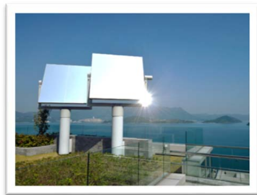
綠景樓中庭頂部的太陽光反射及導入系統
