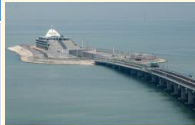
海底隧道及人工島
