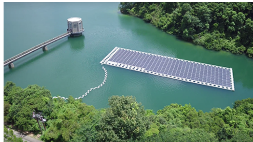
石壁水塘浮動太陽能發電裝置
