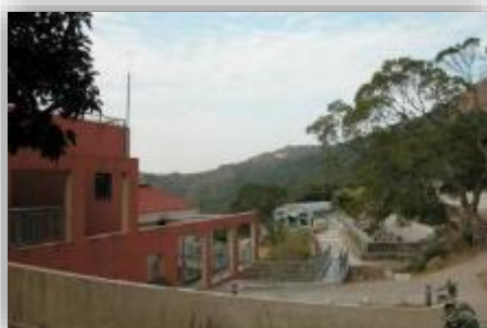
Sze Lok Yuen Hostel 施樂園
